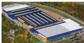
Hörmann KG Eckelhausen, Allemagne
